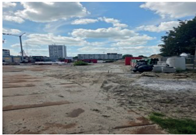
De rijplaten gelegd. Het benodigde materiaal geleverd
