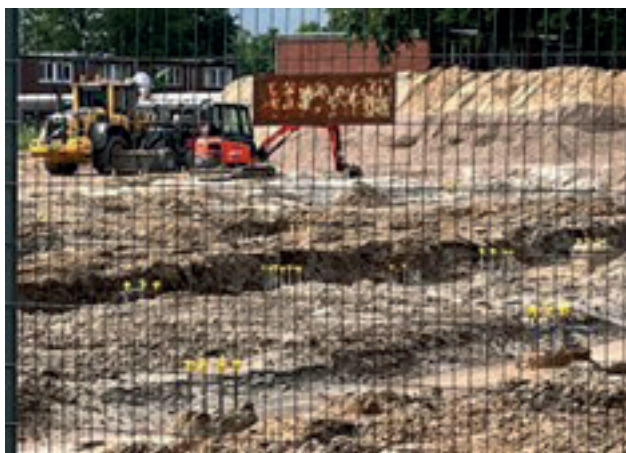
Bezig met het grondwerk
